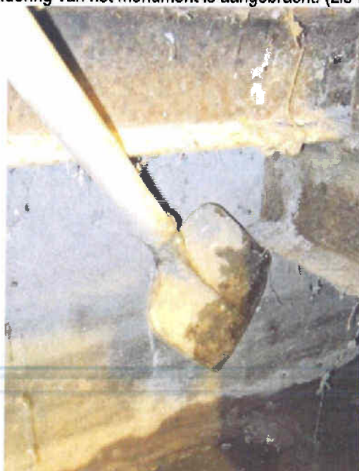
Foto 4 – Stalen ligger ligt niet op op constructie van het monument, maar kraagt uit ten opzichte van funderingsloof onder te slopen bouwdeel. De voorzetwand staat wel op de fundering van het monument, doch heeft geen constructieve functie.
