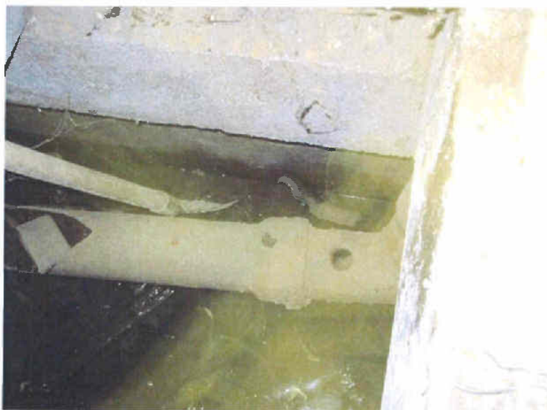
Foto 5 – kapotte riolering onder bestaande te slopen bebouwing
